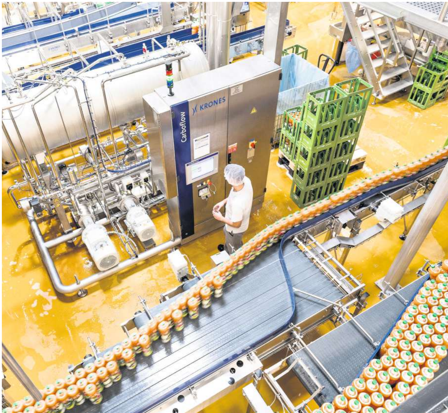
Läuft bereits auf Hochtouren: die neue PET-Abfüllanlage von Ramseier in Sursee.
